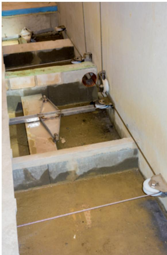
Für die Unterflur Entmistung fertigen wir Kotschlitten, die mit Elektromotor und Drahtseil über Umlenkrollen angetrieben werden.
